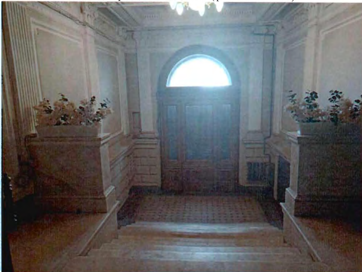
27. Здание 12. Вестибюль парадной лестницы 1ЛК (фото от 27.06.2023).
