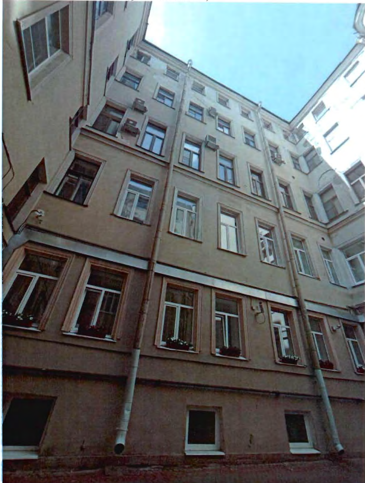
8. Здание 12. Дворовой фасад (фото от 27.06.2023).
