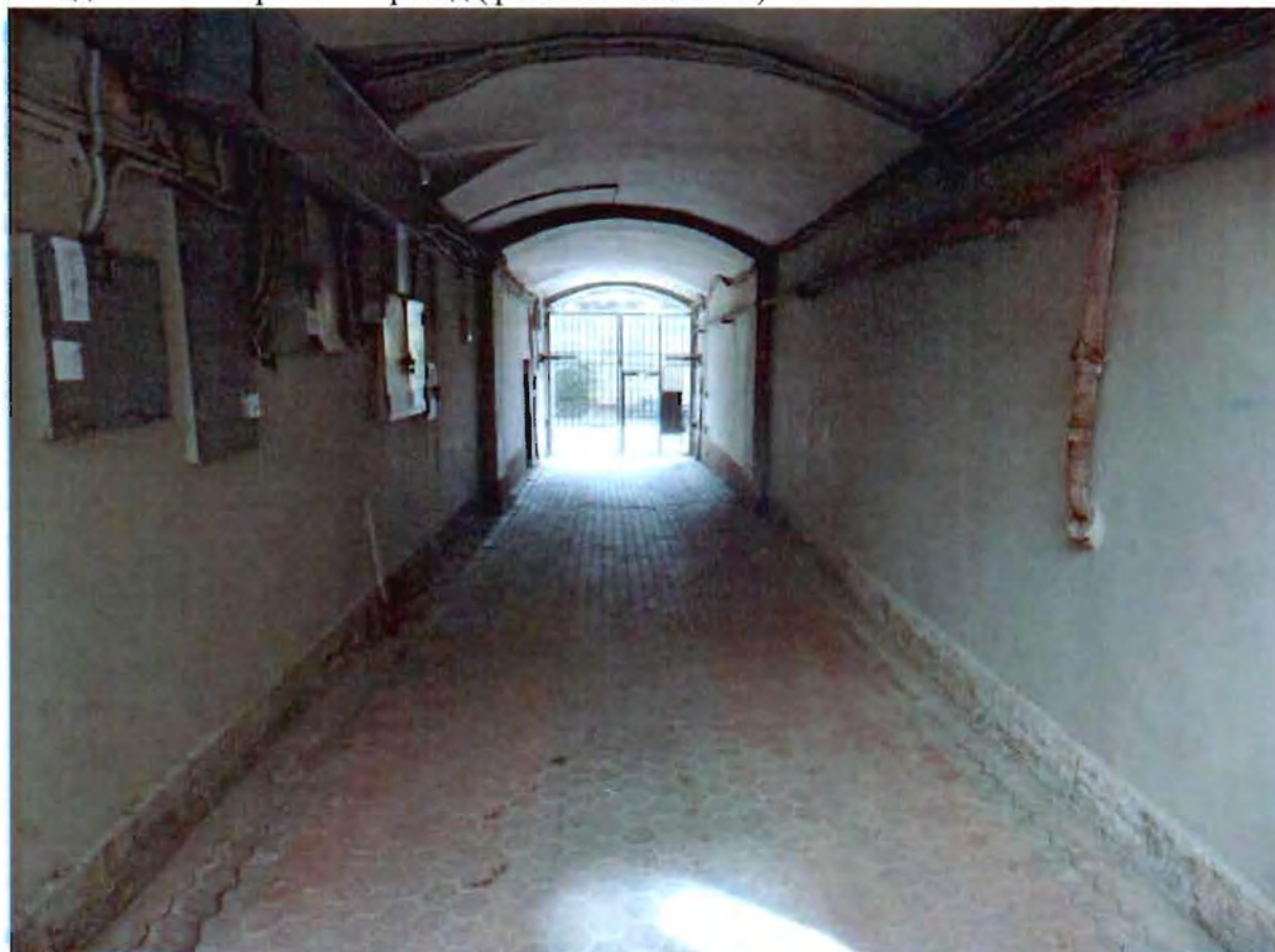
34. Здание 12. Воротный проезд (фото от 27.06.2023).
