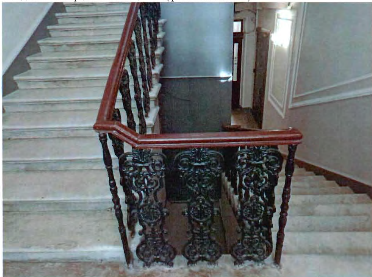
26. Здание 12. Парадная лестница 1ЛК (фото от 27.06.2023).
