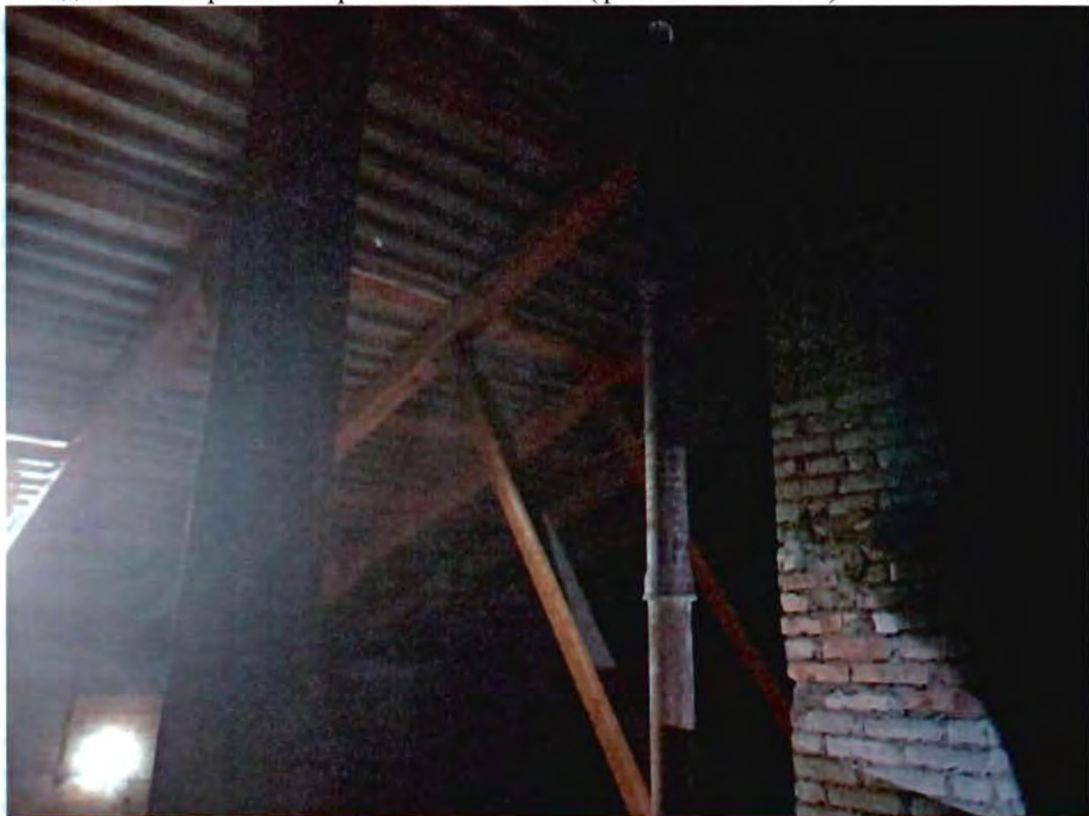
37. Здание 14. Фрагмент стропильной системы (фото от 24.03.2023).
