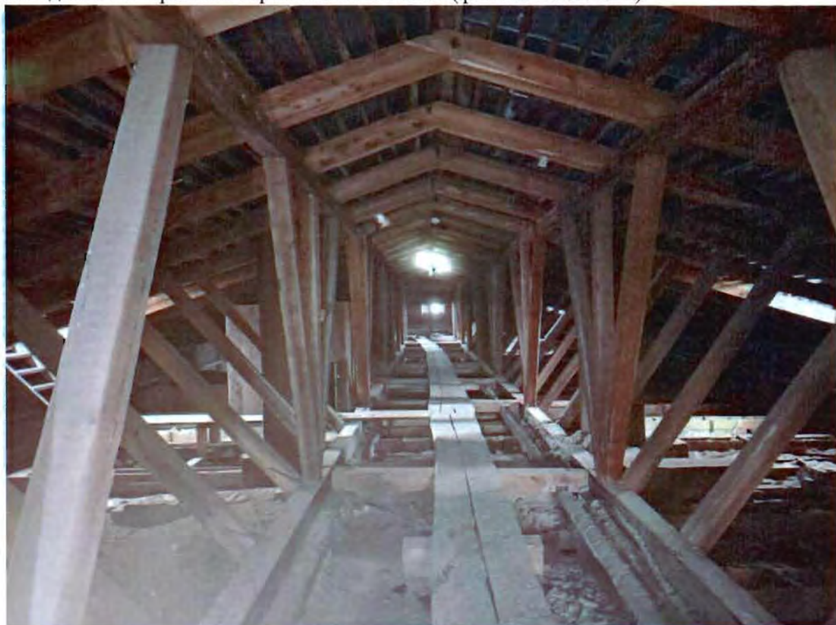
36. Здание 14. Фрагмент стропильной системы (фото от 24.03.2023).
