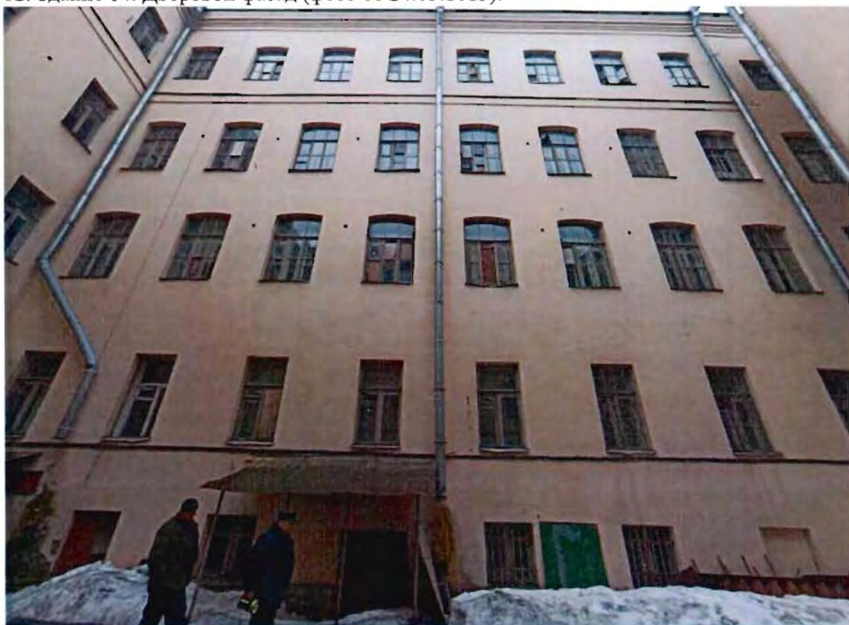
12. Здание 14. Дворовой фасад (фото от 24.03.2023).
