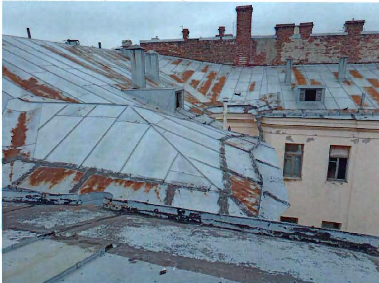
35. Кровля. Покрытие (фото от 24.03.2023).
