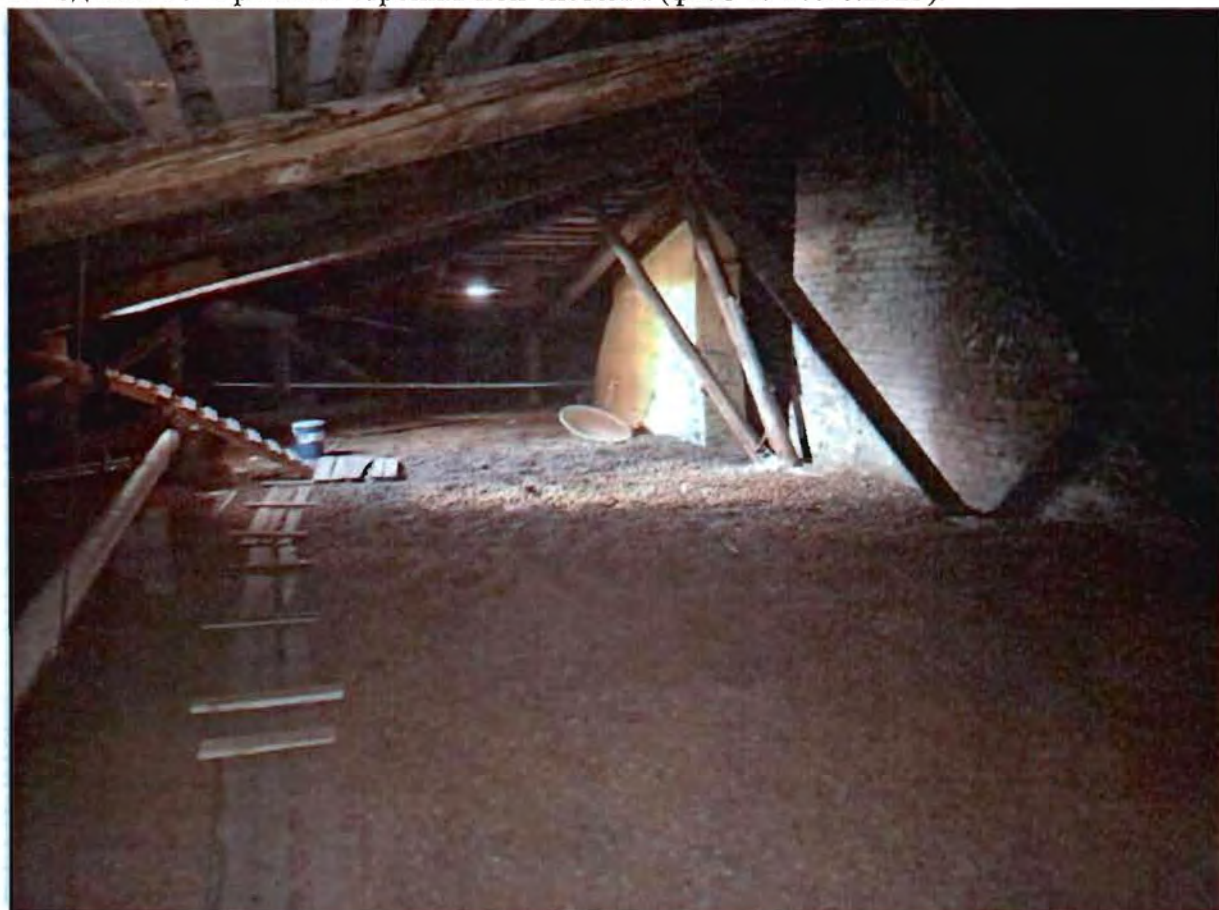
38. Здание 14. Фрагмент стропильной системы (фото от 27.06.2023).
