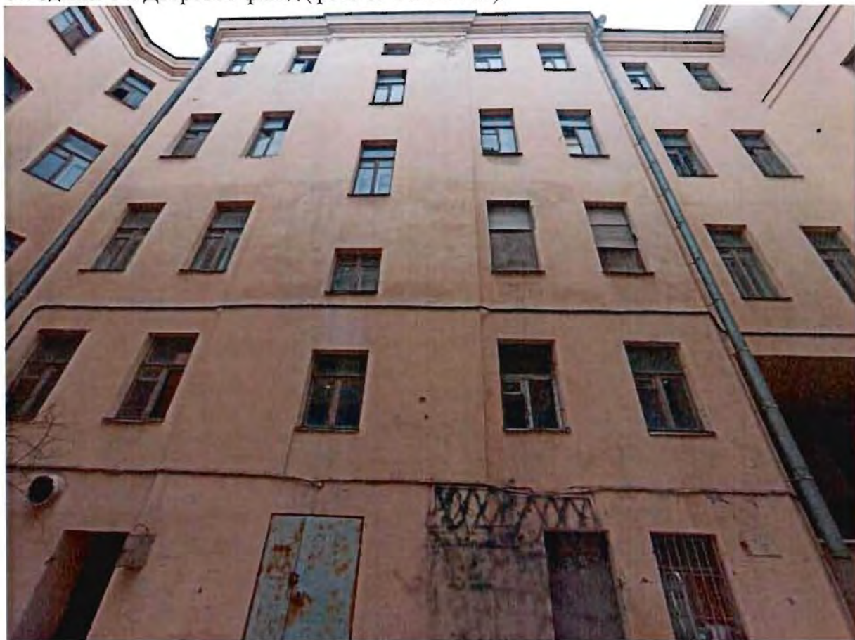
14. Здание 14. Дворовой фасад (фото от 24.03.2023).
