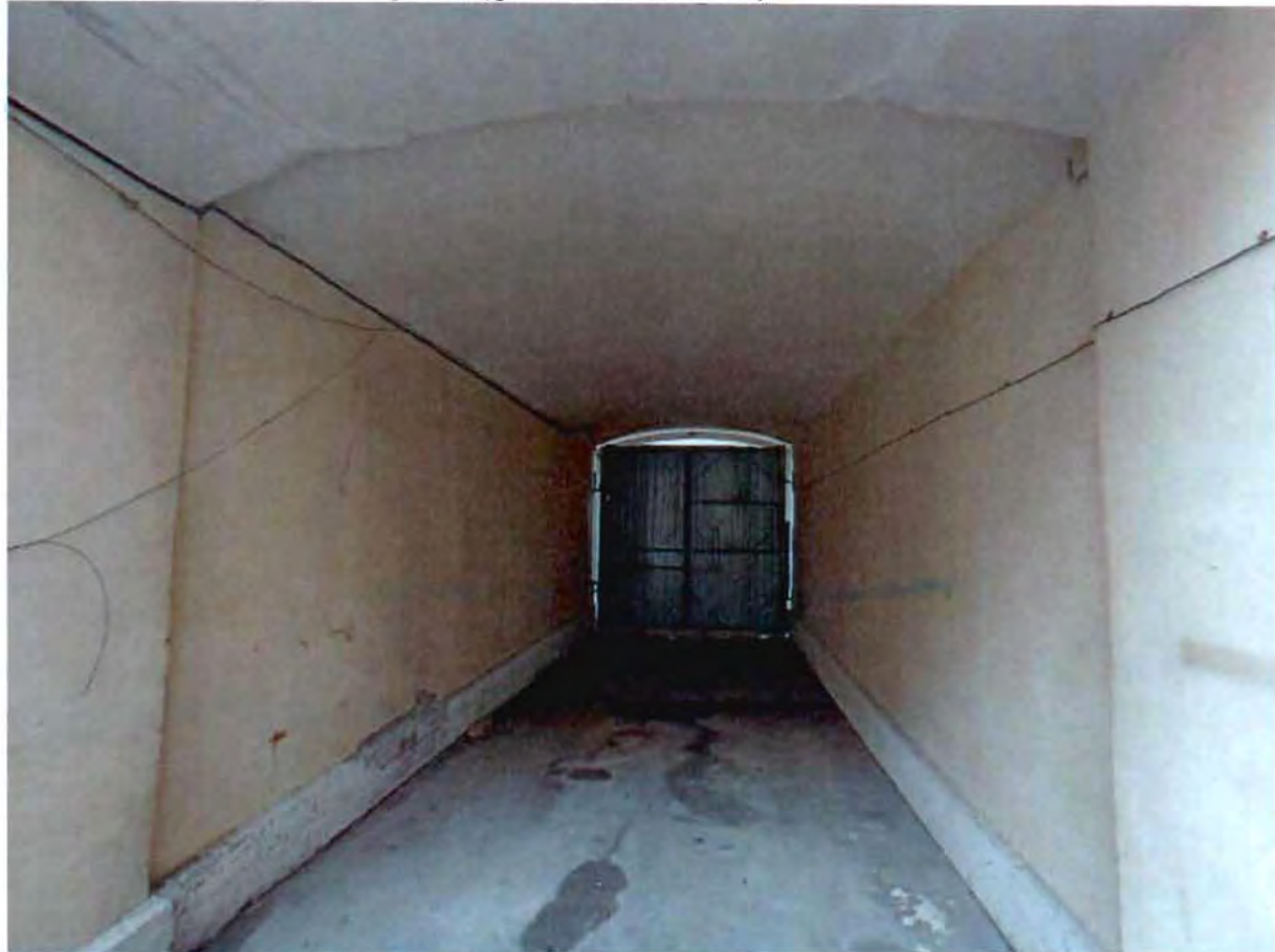
33. Здание 14. Воротный проезд (фото от 24.03.2023).
