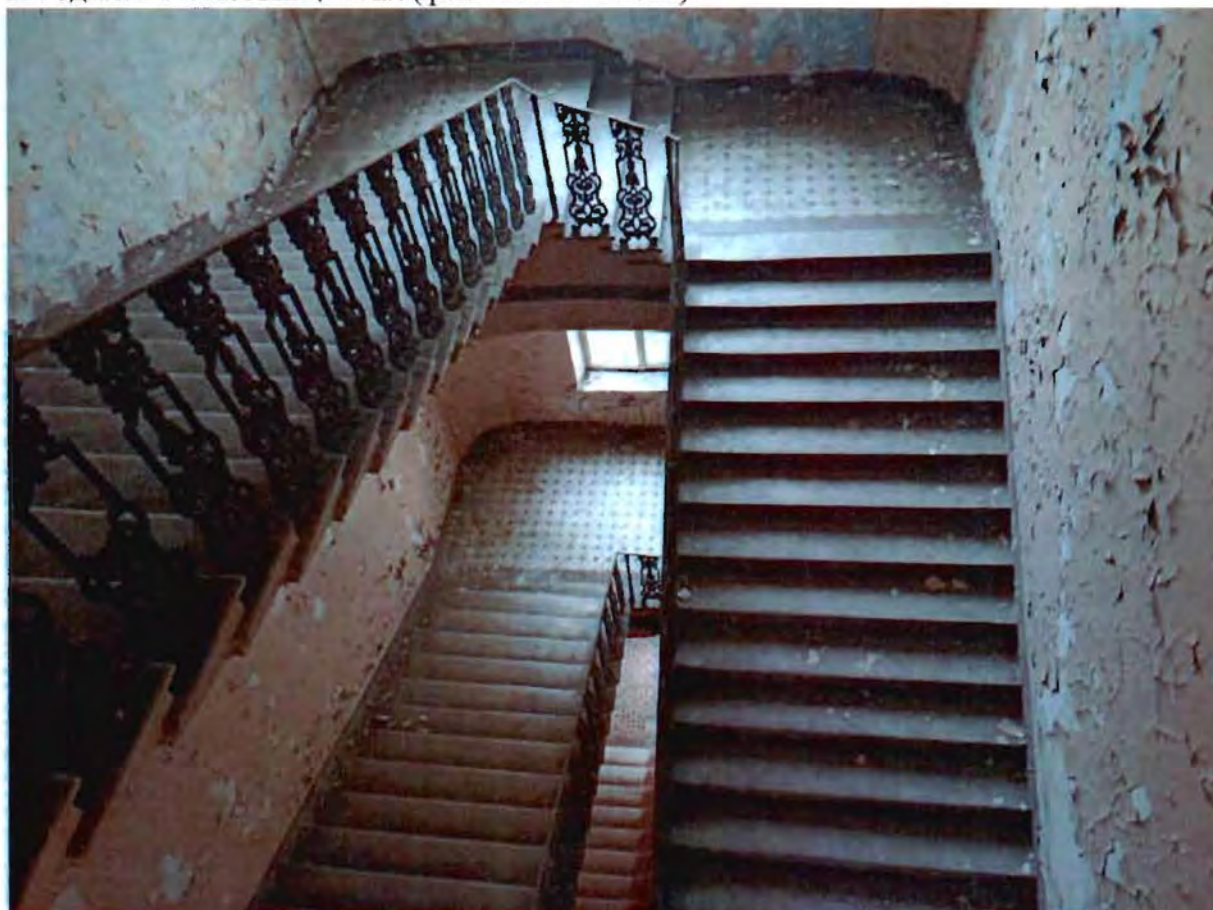
22. Здание 14. Лестница 5ЛК (фото от 24.03.2023).
